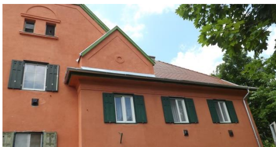
Helyreállított homlokzat a Gyártelepen
