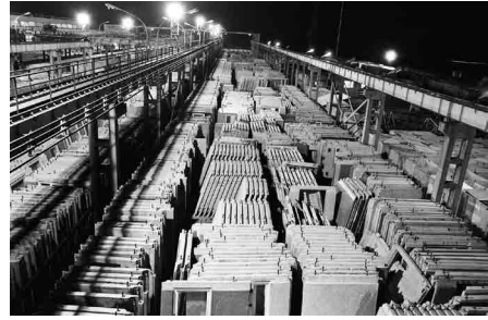
23. kép: Munka a házgyárban
