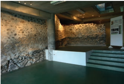
49. kép: A déli erőd fal és a délkeleti saroktorony műemléki helyreállítás után a Dunasor 28. sz. ház alagsorában
