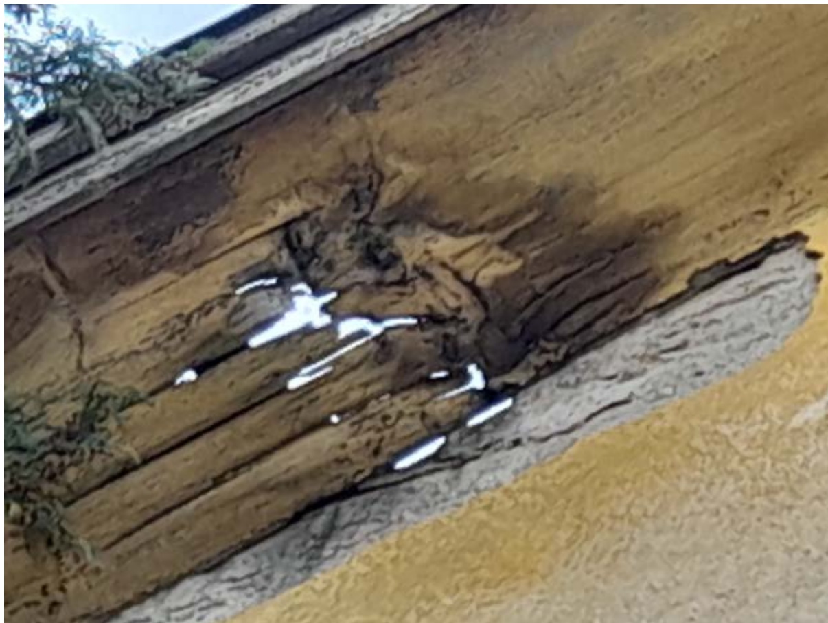
Az ereszalj felülről ázik, korhadt, átlyukadt, így károsodnak a környező épületszerkezetek
